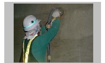
2 躯体の剥離材、セメントのノロ、打継凸部等除去の為、躯体全面にカップサンダー掛けを行います。
