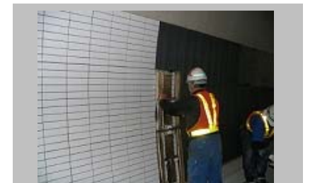
6 型枠張り又は手張りにてタイルを張付します。ヴィプラートをを使用してタイルが全面接着するように圧着させます。
