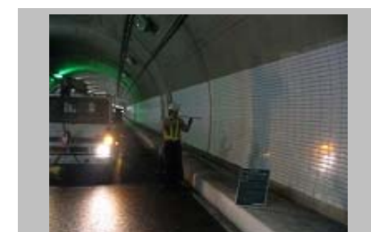
9 高圧洗浄機によりタイル表面の水洗浄を行います。
