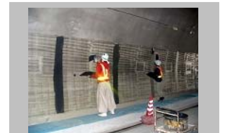
4 躯体のジャンカ、打継凹部を接着剤にて平滑に調整します。
