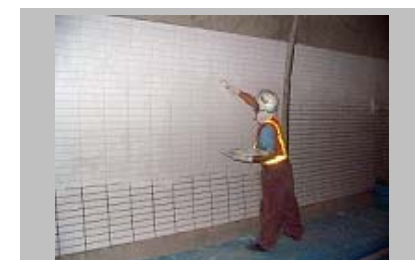
7 目地用モルタルをゴム鏝で目地によく詰込みします。表面に付いたモルタルはスポンジ等で拭取ります。
