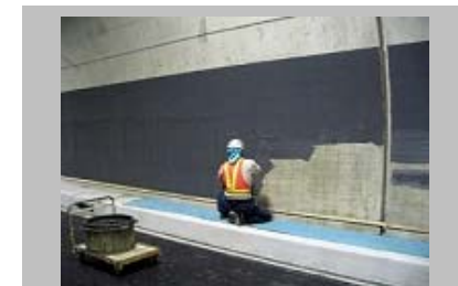
5 攪拌した接着剤をクシ目鏝を使用し施工面に均一に塗り広げます。
