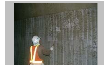
3 コンクリート表面の補強と接着剤の密着性向上の為、プライマーをローラー刷毛で塗布します。
