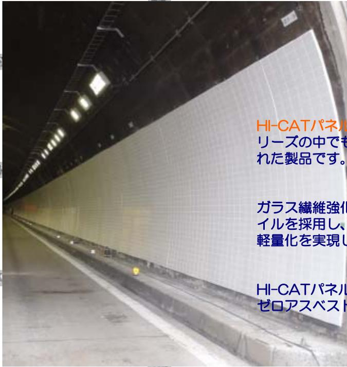
HI-CATパネルR-15は、トンネル内装材として開発されたHI-CATパネルシリーズの中でも特に曲面での直張り施工を可能にし、施工性・経済性にも優れた製品です。
